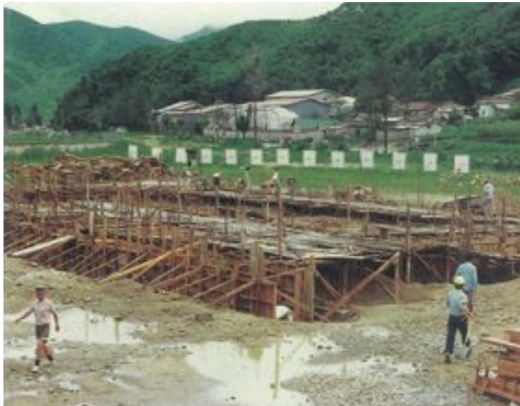
안양공장 본관 건물 기초작업
