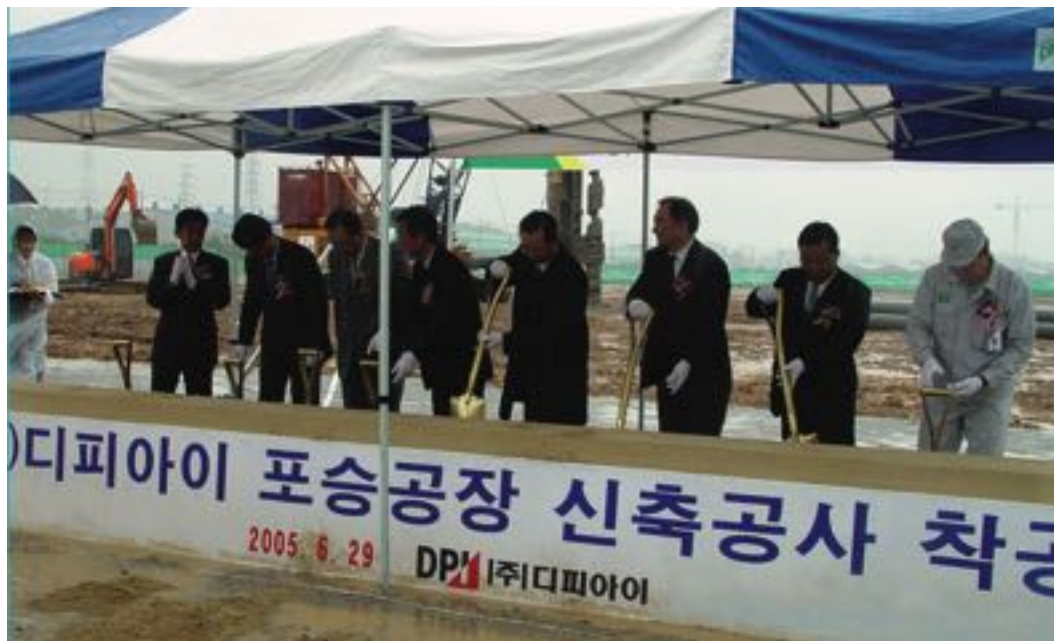
디피아이 포승공장 신축공사 착공식
